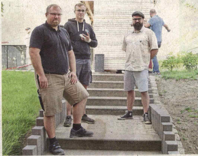
Azubi und angehender Straßenbauer Jan Hübel (Bildmitte) zeigte stellvertretend für alle Lehrlinge im Bereich der Tief- und Straßenbauer/innen die selbst geplante und erstellte Außentreppe. Neben ihm Klassenlehrer Dennis Köpke (links) und Enrico Hahn (BBZ).
