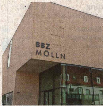
Hier wurde eine teure Fensterscheibe zerstört.
