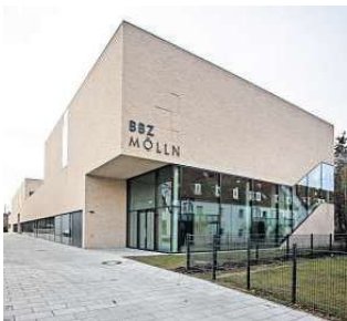
Und so sieht der Neubau mit dem Haupteingang von der Heinrich-Langhans-Straße in der Realität aus.
